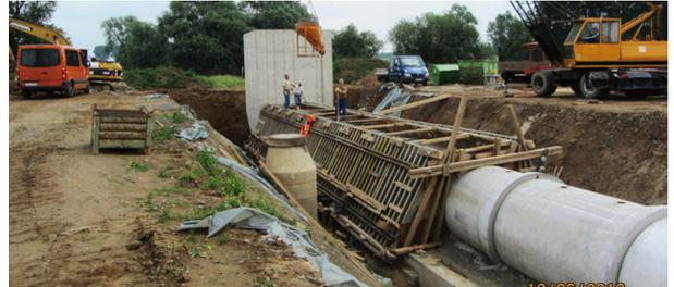
Neben den Erdarbeiten wurde noch gebaut: Ein Durchlassbauwerk für den Stingesbach mit einem Schieberschacht mit zwei eingebauten Absperrschiebern und Anschlüssen aus SB-Rohren. Gleichzeitig wurde die Spundwand mit Klinkern verkleidet. Parallel zum Erdbau wurde der Wegebau für den Deichkronenweg mit rotem Pflaster und für den Deichverteidigungsweg mit grauem Pflaster ausgeführt. Die Rampen werden zum Teil in Asphaltbauweise ausgeführt.
