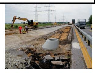
Der Kanalbau begann mit vier Kolonnen; die Verlegetiefen variierten zwischen zwei bis fünf Metern. Zum Einsatz kamen Betonrohre DN 700 und Kunststoffrohre DN 150-500 sowie Beton- und Kunststoffschächte. Bis zur Fertigstellung werden 1.700 m Beton- und 6.400 m Kunststoffrohre verlegt.
