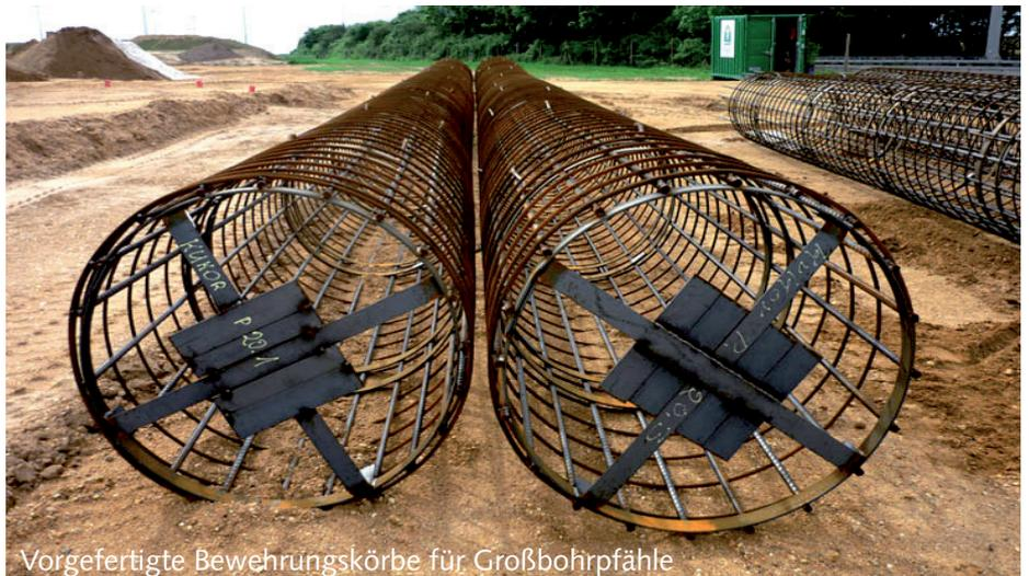
Vorgefertigte Bewehrungskörbe für Großbohrpfehle
