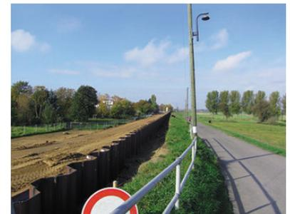
Die Spundwand bleibt in einer Höhe von ca. 1,30 Meter an der Oberfläche zu sehen, wird aber durch eine durch eine ansprechende Verklammerung harmonisch in das Umfeld eingefügt.
