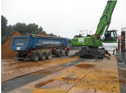
Die Besonderheit bei der Deichsanierung in Meerbusch-Lank ist die Anlieferung des Materials mittels Schiff. Dazu war ein Schiffsanleger als Anlege- und Umschlagstelle zu errichten; hier werden die Schiffe gelöscht und das Material wird mittels LKW in die Baustelle gefahren. Umfangreiche Nassbaggerarbeiten und Auffüllungen des Anschlussgeländes sind notwendig.
