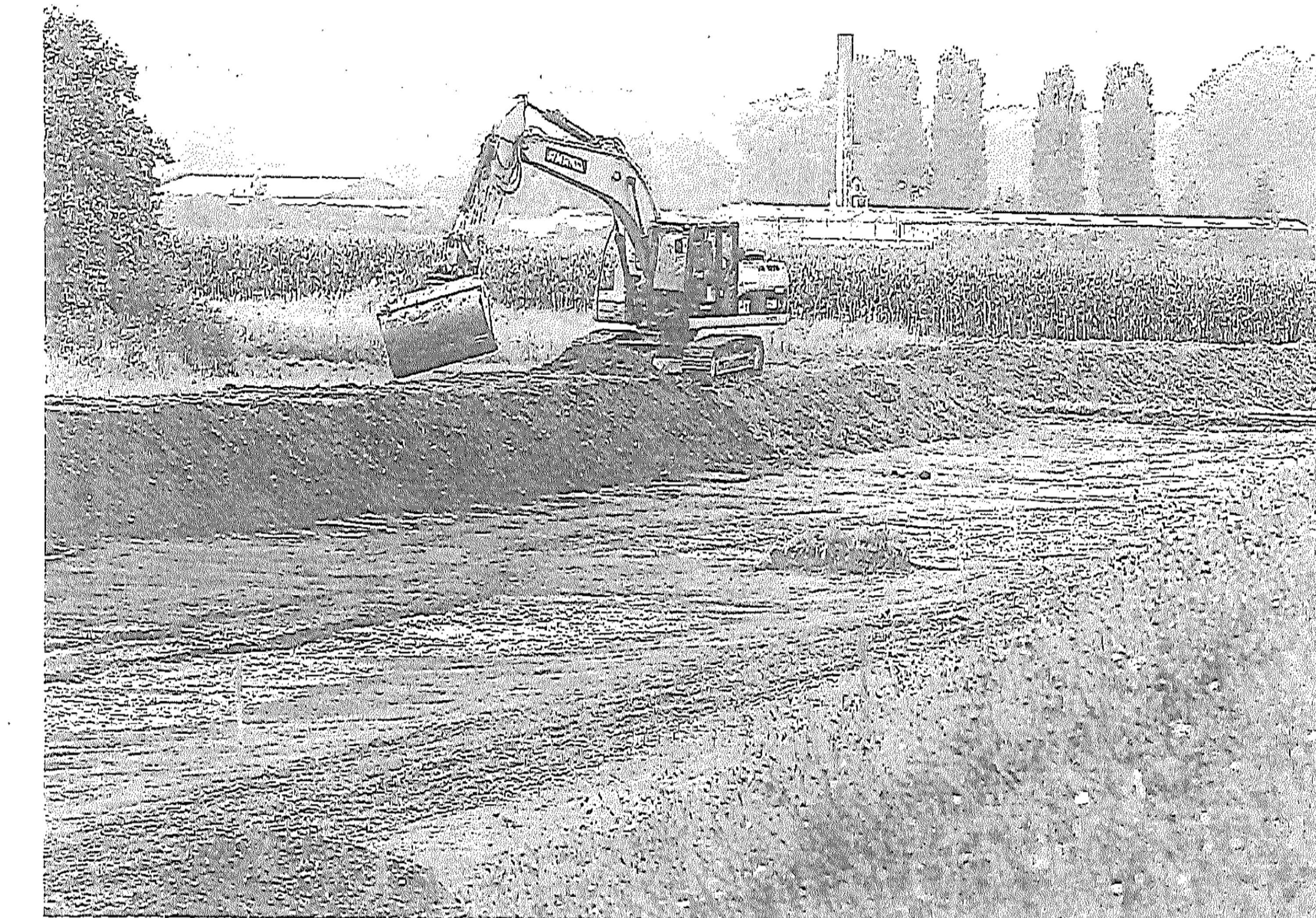
Zurzeit wird der alte Deichfuß abgebagert, um die Beton-Spundwand zum Schutz der Abwasserleitung zu erstellen. Diese Arbeiten können auch im Winterhalbjahr fortgesetzt werden.
