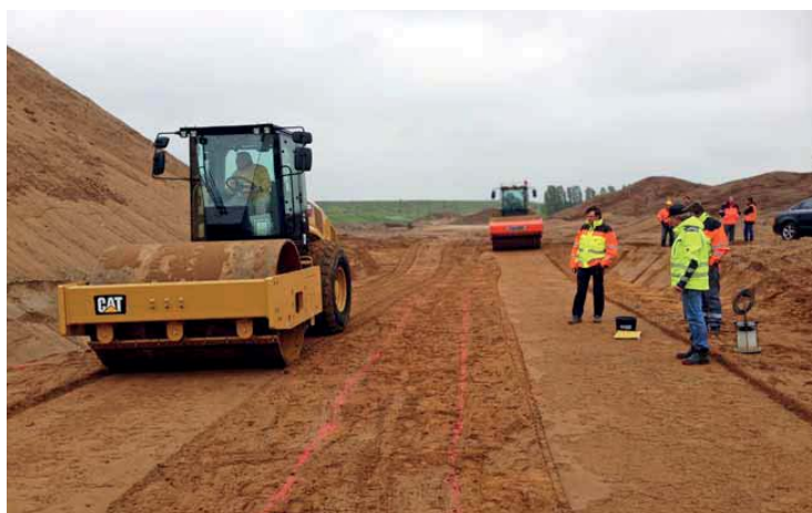
Der Walzentest hatte zum Ziel, bei grobkörnigen Böden im oberen Meter eine Procterdicke von hundert und mehr Prozent zu erreichen. Foto: Zeppelin
